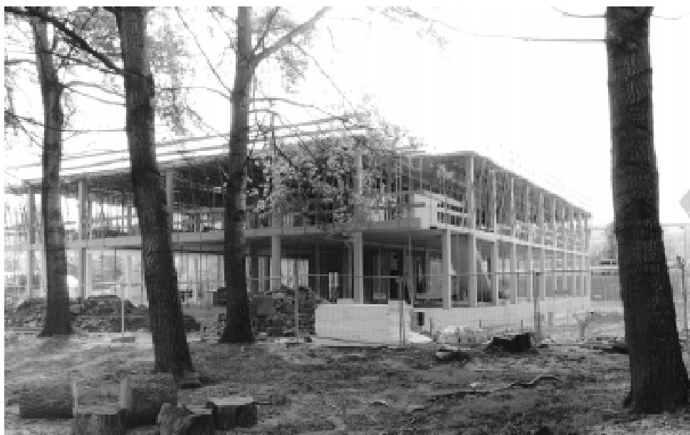
Fig. 7. Construction of the new Hubrecht Laboratory, de Uithof, Utrecht 1999.
